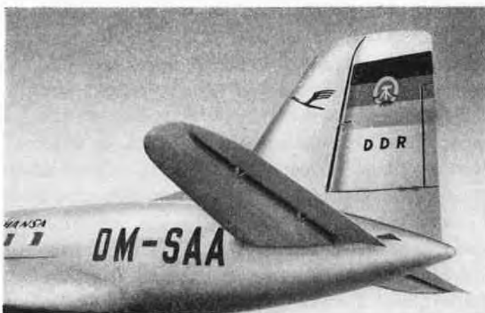
△ Bild 2.7 Einfaches Leitwerk (IL 14 P)
